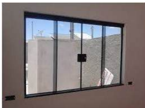
Figura 4 - Janela vidro temperado 8mm e alumínio
