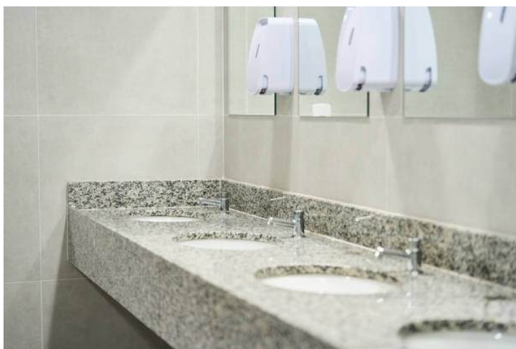
Figura 8 – Lavatórios em granito e cuba embutida
